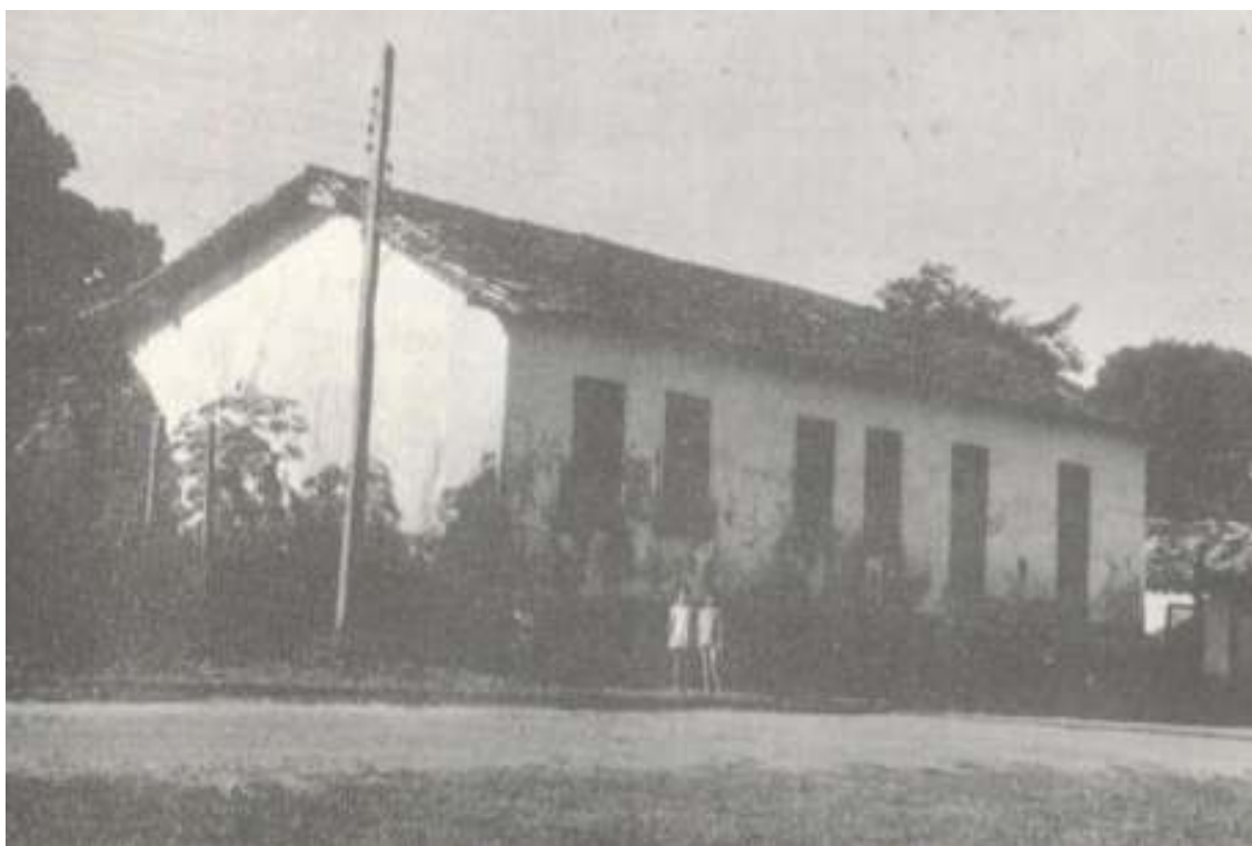
Figura 05: Casa do Coronel Joaquim Ayres Cavalcante Wolney. Em 1975, as únicas alterações verificadas eram os fios da instalação elétrica, os meios-fios e o muro caído, à esquerda.
